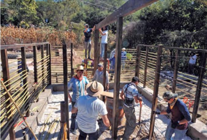
IMAGEN 06 | Materiales de muros y estructura de pajareque
