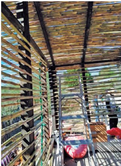
IMAGEN 05 | Sistema de muros y cubierta de pajarique
